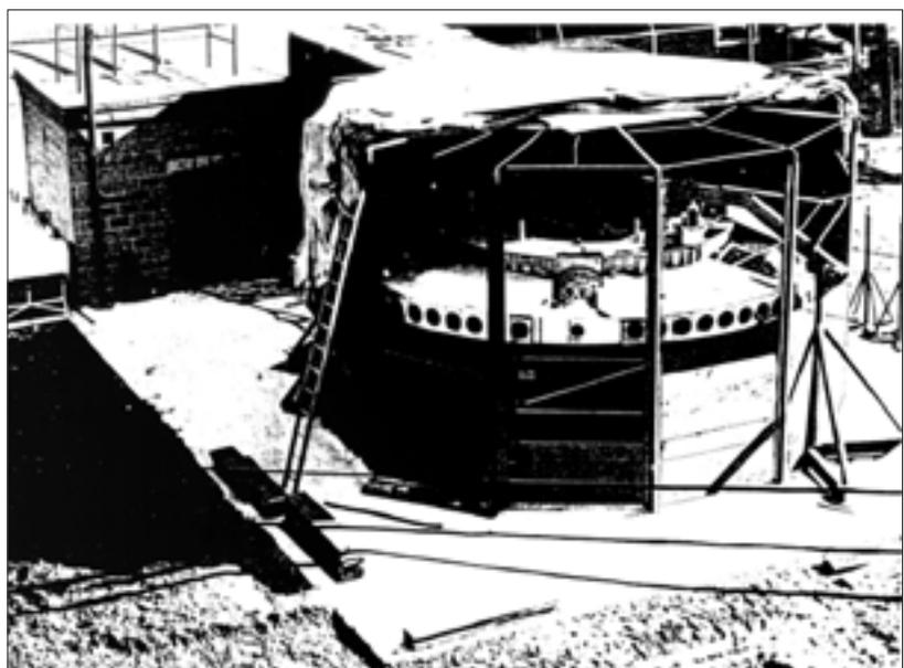
Der Avro-Prüfstand für die Mach-4-Flugscheibe des Projekts 1794
